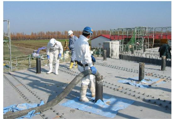
図-24 高流動コンクリートの打設状況
