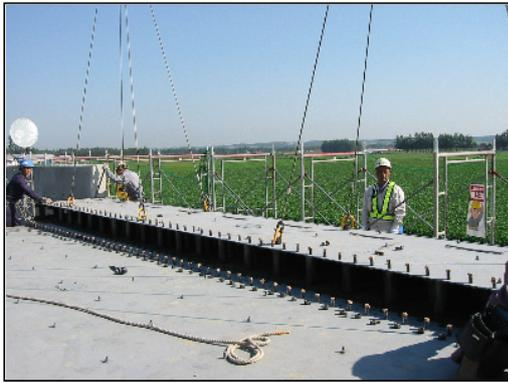
図-23 サンドイッチ頂版の架設状況
