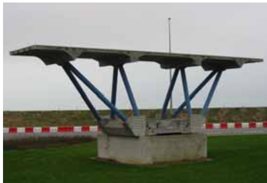
写真-1 ブローネ高架橋のセグメント
