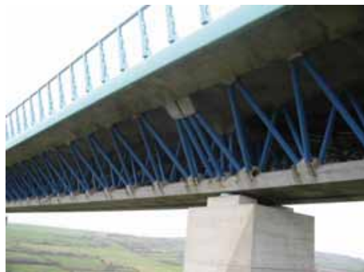
写真-3 ブローネ高架橋の柱頭部構造
