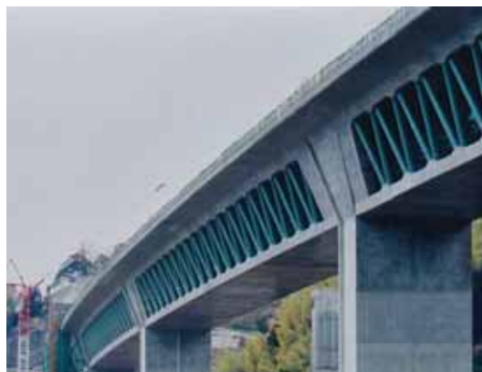
写真-4 猿田川橋の柱頭部構造
