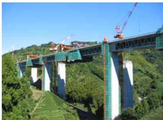
写真-6 張出し架設状況
