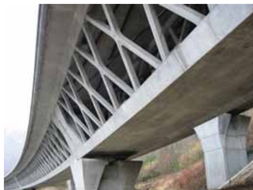
写真-2 シラン高架橋
