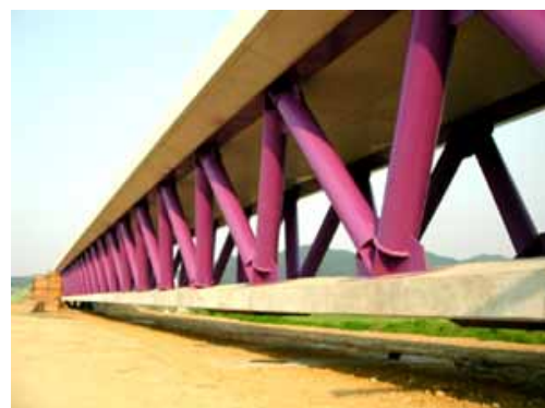
写真-1: 試験施工された複合トラス桁橋 (実物)
