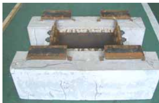
写真-1. 供試体破壊状況
