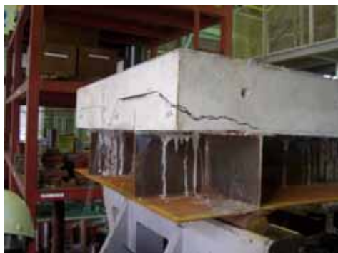
写真-2. 床版端部のひび割れ状況
