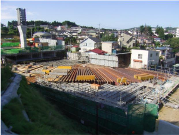
写真-3 仙台市道上空H型鋼敷設状況
