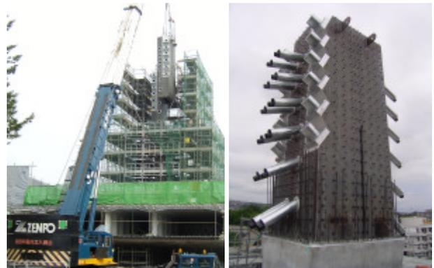
写真-2 主塔鋼殻セル設置状況
