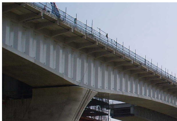
写真 4 柱頭部付近の波形鋼板の外観
