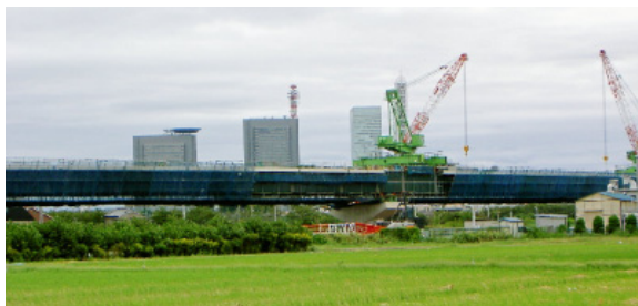
写真-2 見沼高架橋（渡河部付近）の桁架設状況
