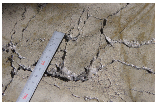
写真-1 防水層無しのコンクリートの破壊状況（タイプB・32万往復回）
