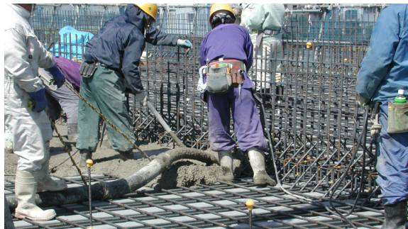
写真-3 コンクリート打込み状況
