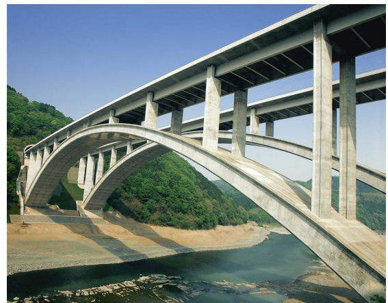
写真-1 第二東名富士川橋 完成写真（2005年6月撮影）
