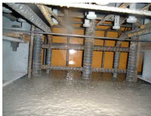
写真 3 接合部下フランジ下面の状況
