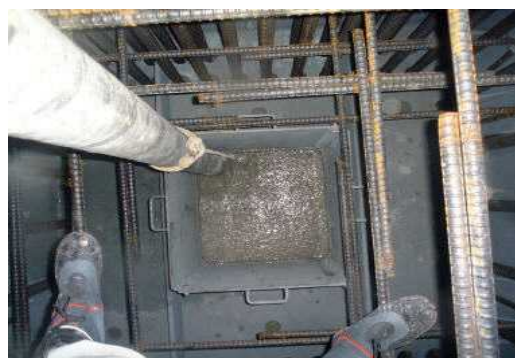
写真 4 鋼桁下面ホッパー内の充填状況
