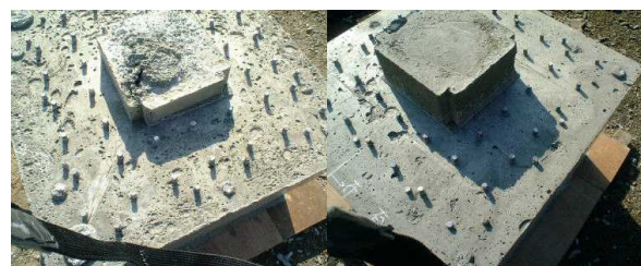
写真 1 コンクリートの表面状況
