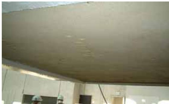
写真 - 2 吹付系耐火材燃焼後 (type-2)
