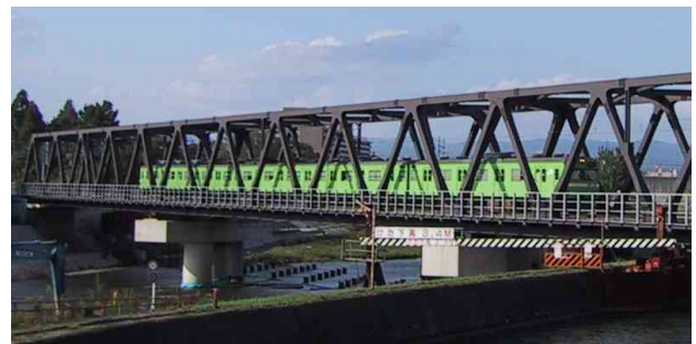
(a) J R 西日本・奈良線・鴨川橋梁
