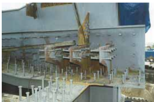
写真-2 桁端部のスタッド配置例
