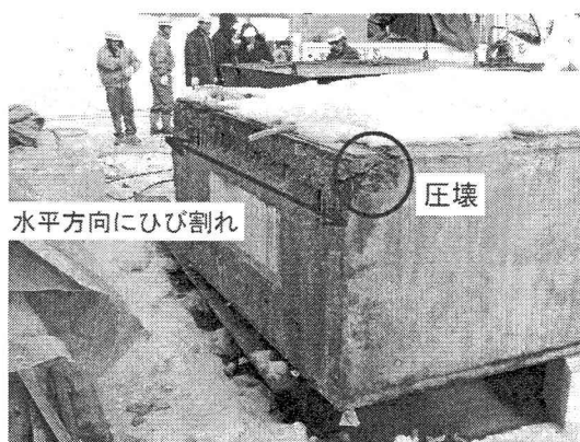
接合面 (P C桁側)
