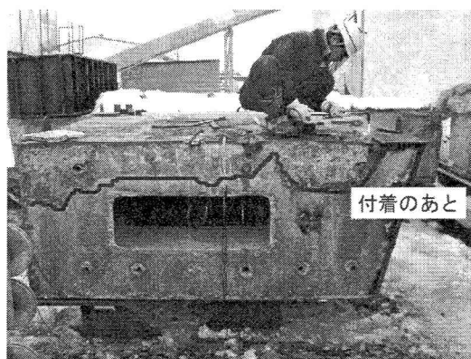
接合面 (鋼桁側)
