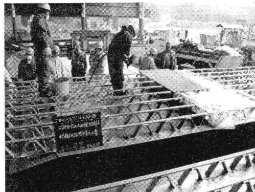
a) 施工試験状況
