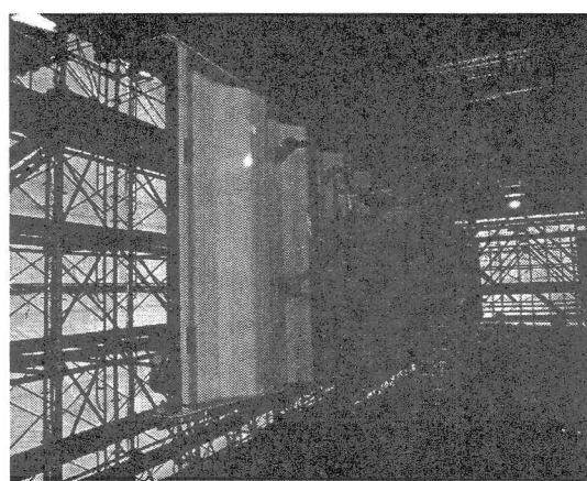
写真-2 波形鋼板の架設
