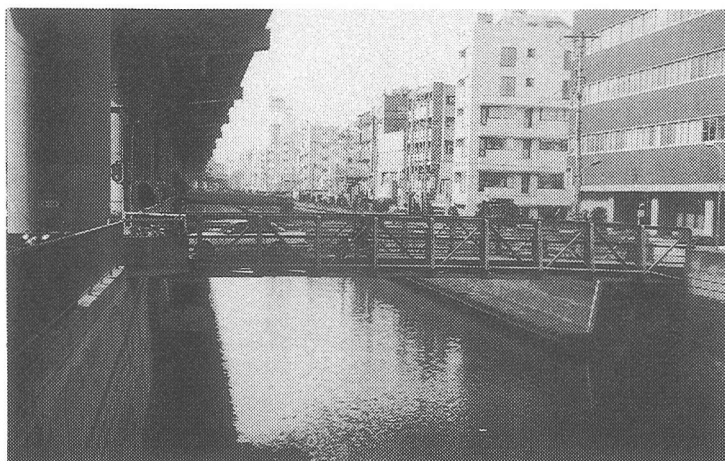
写真-2 中之橋・旧橋
