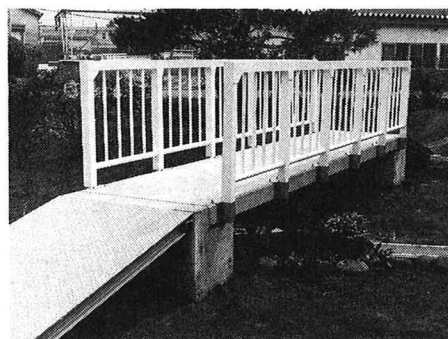
写真-8 完成したPC床版歩道橋
