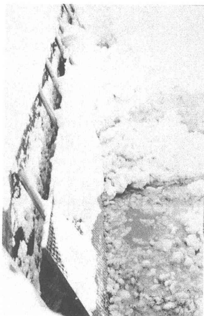
図5 用水内消融雪ネット 実用実験の状況
