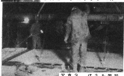
写真3 パネル架設
