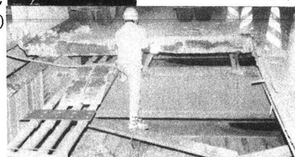
写真8 2格間解体、縦桁撤去
