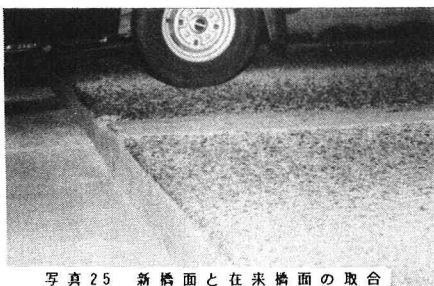
写真25 新橋面と在来橋面の取合
