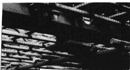
写真19 埋込H鋼とT形鋼
