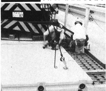
写真22 パネル継手
