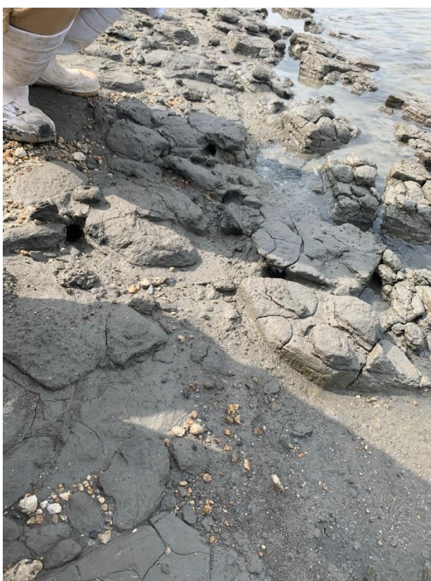
図-9 壁面付近からの漏水
