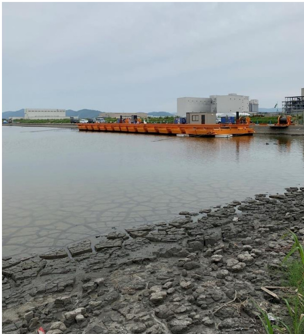
図-3 現場写真(2021年9月)
