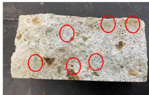
図-13 繊維状の構造を表面に有する機械切断した大谷石の面(赤丸で囲った部分が繊維の束のような構造の箇所)
