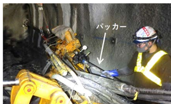
写真-3 パッカー挿入状況
