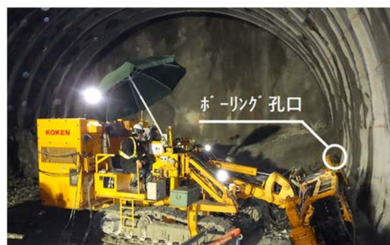
写真-2 先進ボーリング削孔状況
