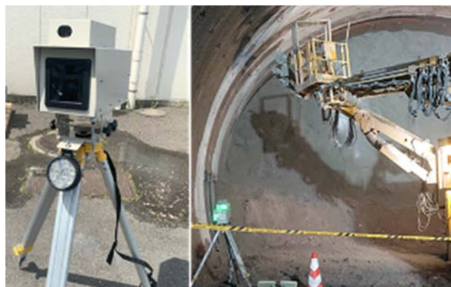
写真-1 落石監視装置(左)、切羽監視状況(右)
