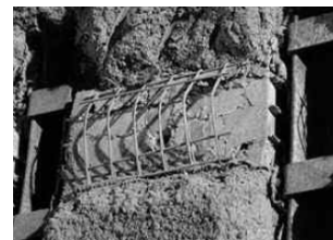
写真-1 hiDConの施工事例 3)
