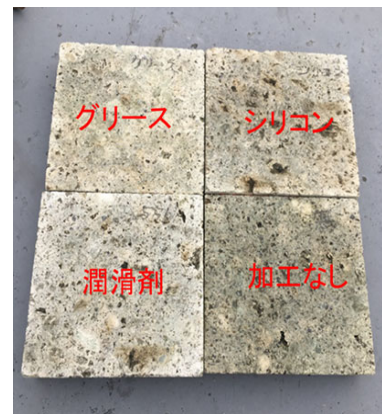
図-12 雨で濡れた後の大谷石細目の様子(塗布後約4ヶ月経過)
