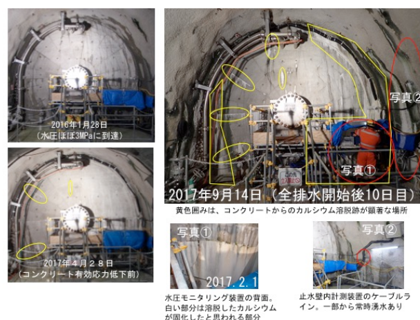
図-8 第2回目機能確認試験開始～終了直前までの止水壁及び近傍の状況写真
