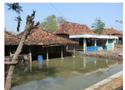
(c) 沈下により浸水している住居
