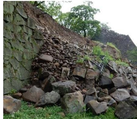
写真-1 熊本城崩壊の様子 (熊本城 三間櫓跡)
