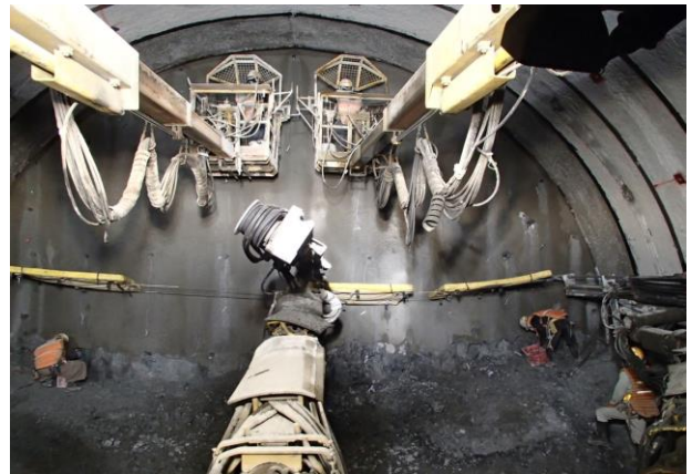
写真-1 切羽における作業状況
