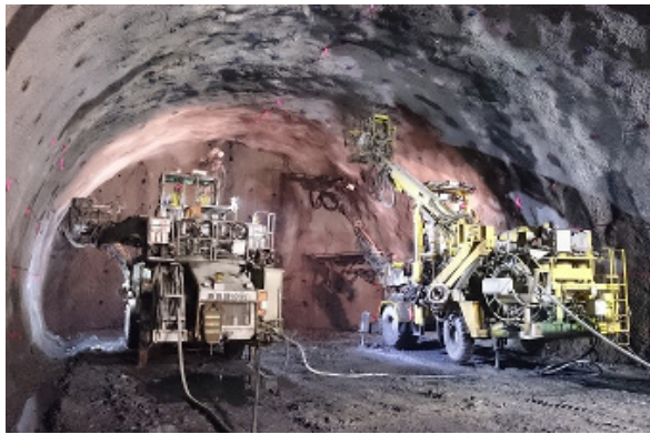
写真-4 トンネル切羽の作業状況
