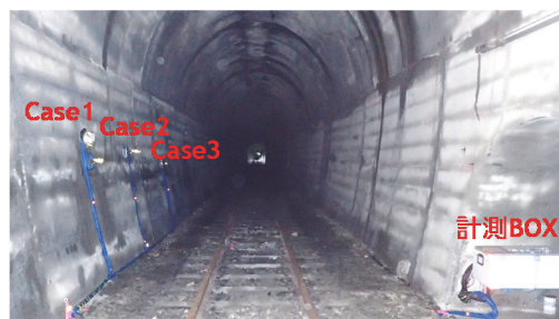
写真-1 試験施工完了状況
