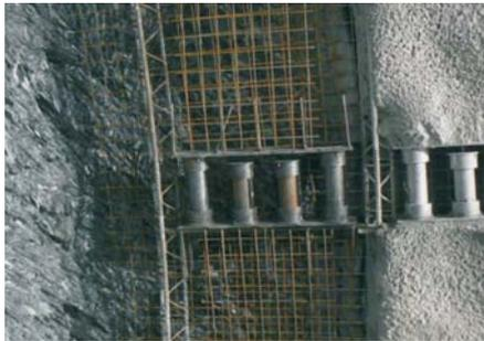
写真-1 Lining Stress Controllers (LSC) 採用例<sup>3)</sup>
