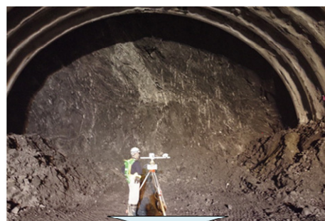
写真-3 3次元計測の仕組み
