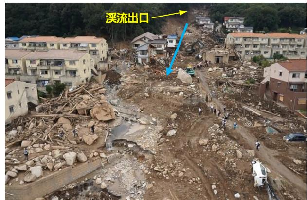
写真-2 溪流出口下流部の巨礫の流出状況<sup>2)</sup>
