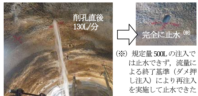
図-8 大量湧水のグラウト孔の溶液型グラウトによる止水結果
