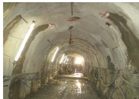
図-10 ポストグラウチング完了直後の全景 (No.6リング付近よりNo.1リング側を望む)
