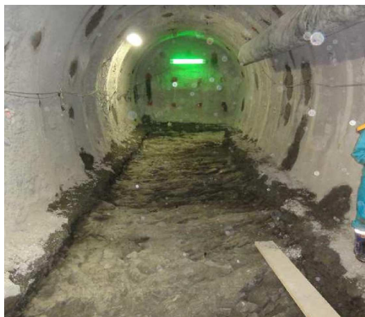
写真-1 試験実施箇所底盤（深度 350m）
