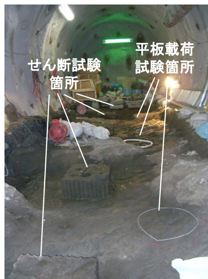
写真-2 試験箇所全景（深度 350m）
