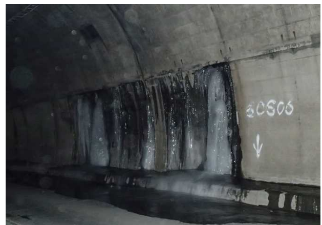
写真-1 冬季の側壁に見られる氷柱
