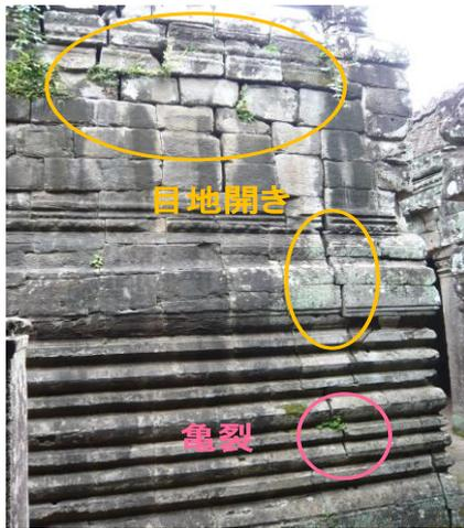
写真-2 基壇部における石材の目地開き・亀裂
