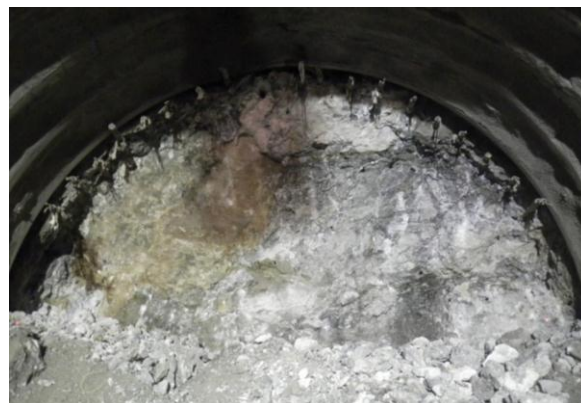
写真-5 切羽状況
