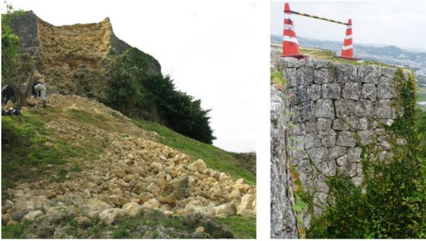
図-2 2010年2月27日の沖縄近海地震による勝連城址の被害
