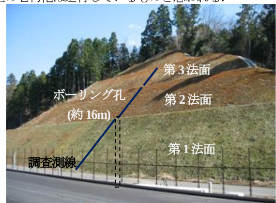
図-2 研究対象法面の全体図
