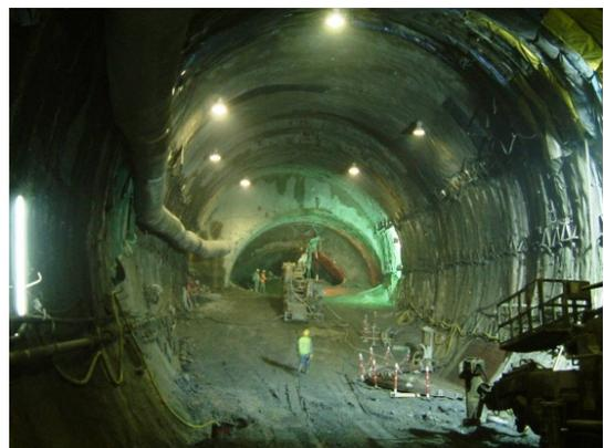
写真-2 PFV-Lの掘削状況
