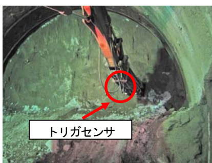
ブレーカーに取り付けたトリガセンサ
