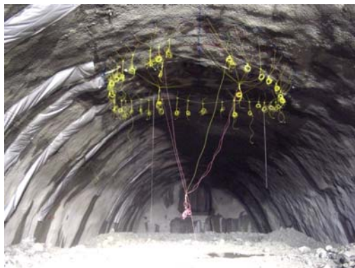
写真-4 竖坑プラグと貯槽空洞天端の接合部の掘削
