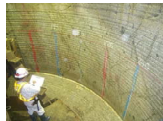
写真-3 Super-RD による掘削壁面状況
