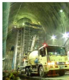
写真-7 コンクリートの打設状況
