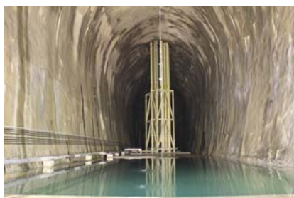
写真-1 貯槽空洞と配管堅坑設備
