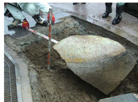
写真-4 掘削後の転石の状況
