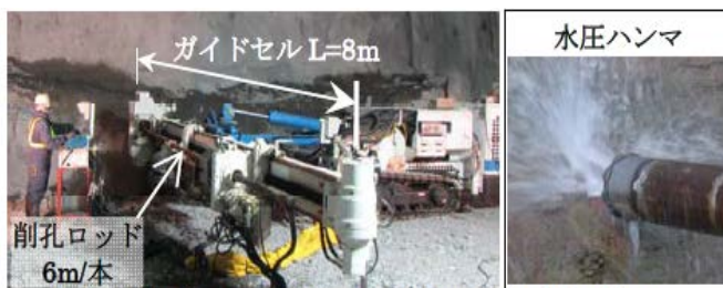
写真 1 高速ノンコアボーリングシステム削孔状況
