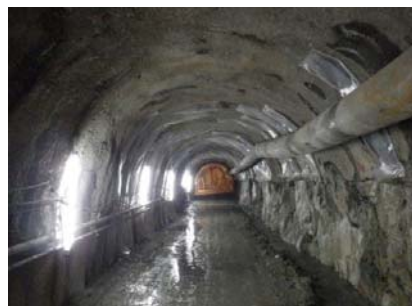
図-9 掘削終了後の深度 500m 研究アクセス南坑道
