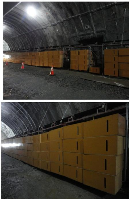
写真-2 吸音ボックス設置状況
