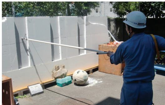
写真-1 突き棒法による打球探査試験状況
