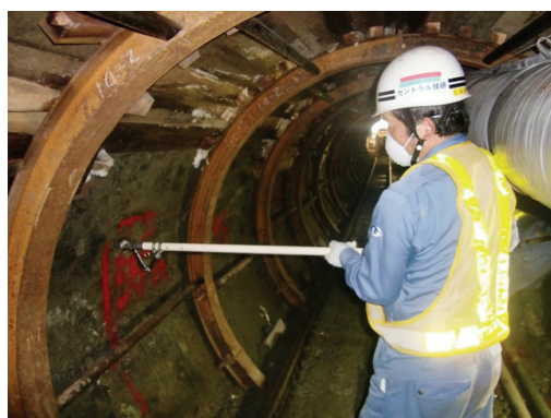
写真-6 突き棒法打球探査の実施状況 (Bトンネル)
