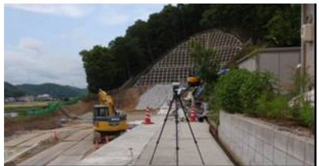
写真-4 音圧測定の機器設置状況
