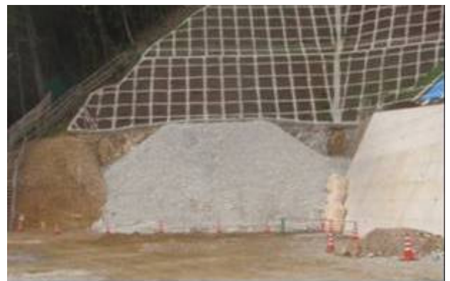
写真-3 出口側坑口法面の音圧測定時の状況
