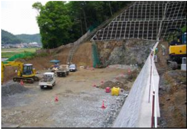
写真-1 出口側坑口法面の音響放射面測定時の状況
